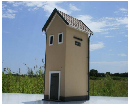
Trafohaus mit Satteldach 23 220
